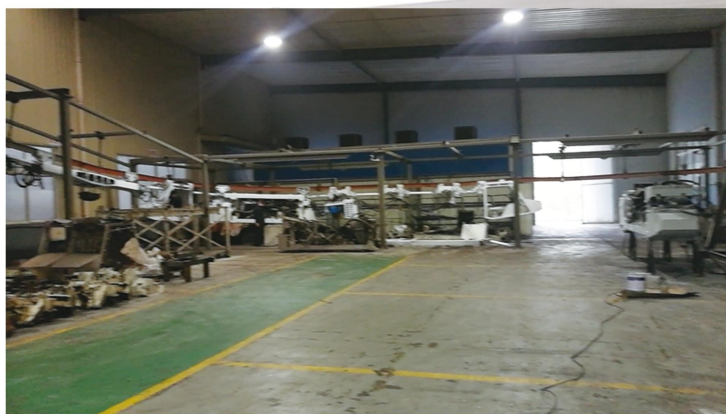
维修完工后 整机带起吊梁运行试车中
