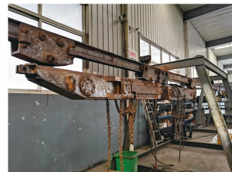
维修中的捷克芬瑞特16T起吊梁
